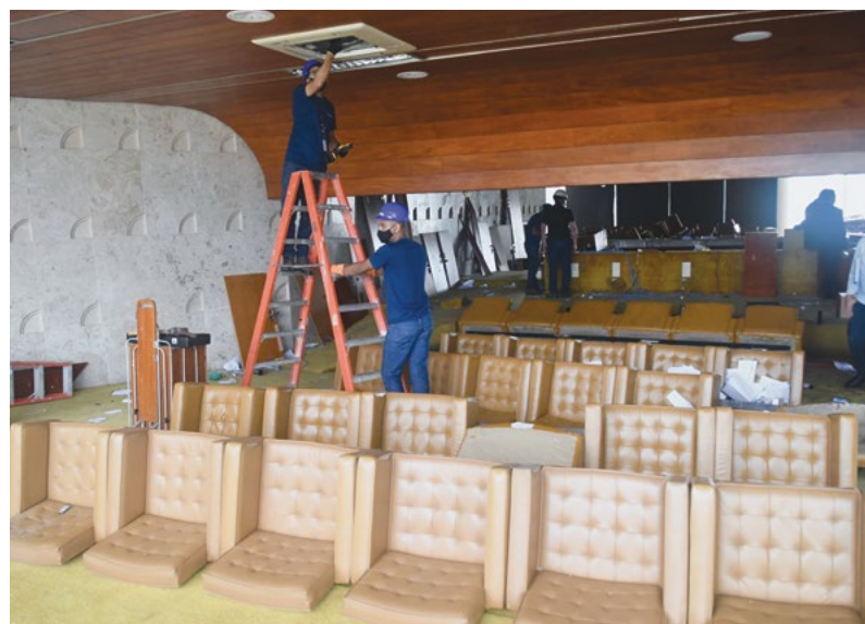
Equipes de trabalho se unem para recuperar o Plenário.
